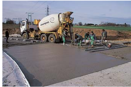
Mise en place du béton à l'aiguille et à la règle vibrantes.
