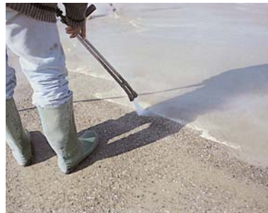
Traitement de surface par dénudage des gravillons du béton (retardateur de surface et lavage à l'eau haute pression).
