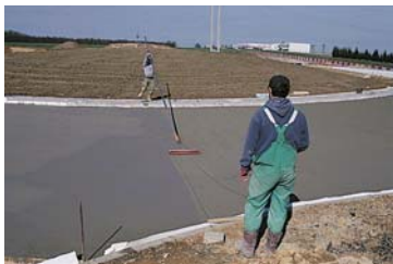
Traitement de surface par balayage.
