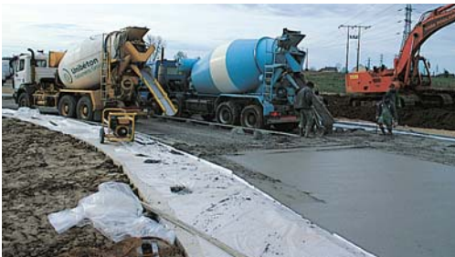
La mise en œuvre du béton nécessite l'utilisation d'un matériel simple et léger, particulièrement adapté à la réalisation des carrefours giratoires (taille et phasage).
