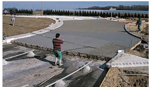
La mise en œuvre du béton nécessite l'utilisation d'un matériel simple et léger, particulièrement adapté à la réalisation des carrefours giratoires (taille et phasage).
