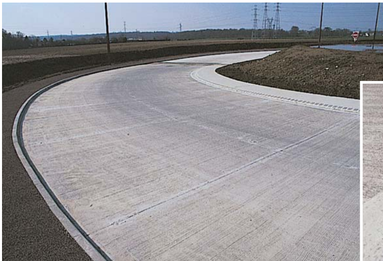
La plasticité du béton autorise la réalisation de systèmes d'assainissement intégrés au revêtement
