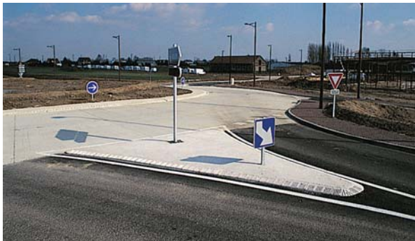
La clarté du béton contraste avec l'espace environnant et améliore la visibilité à l'approche des carrefours giratoires.
