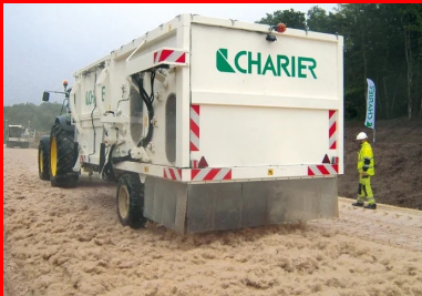
Epdandage de la fibre de chanvre à l'aide d'un matériel spécifique.
