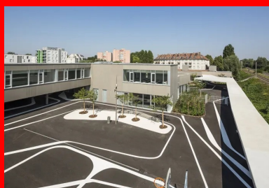
Les cours de récréation (ici, celle de l'école élémentaire) sont protégés des nuisances de voies ferrées par un mur écran.
