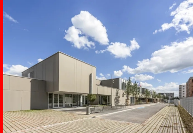
Le groupe scolaire et le gymnase s'inscrivent dans un bâtiment dont l'enveloppe dessine un écran fédérateur et qualifie l'espace public de la promenade.
