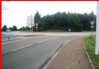
Carrefour giratoire Euro Chanel à Neuville-Lès-Dieppe (RD925). Structure BCig sur couche de forme, réalisée en 1995.
