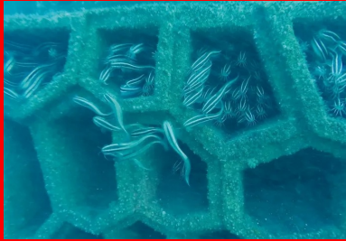
Le CCV, Composite Ciment Verre, et ses alvéoles irrégulières, plébiscités par les poissons sur la route du Littoral.
