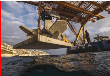
Dans le parc des Calanques, mise à l'eau du Fractal®, avec des moyens de levage exceptionnels.
