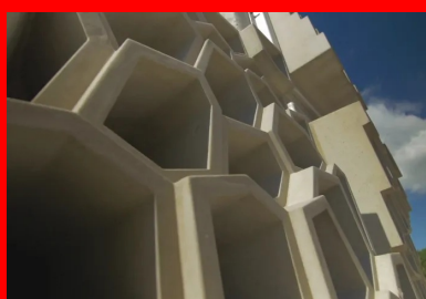
À la Réunion, le Panal®, « casier » alvéolé en CCV, conçu pour résister à une pression de plus de 10 tonnes par mètre carré.
