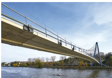
Le tablier en béton franchit l'Oise en une seule travée de 80 m.
