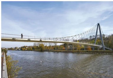
Pour ne pas gêner la navigation, l'ouvrage est suspendu.
