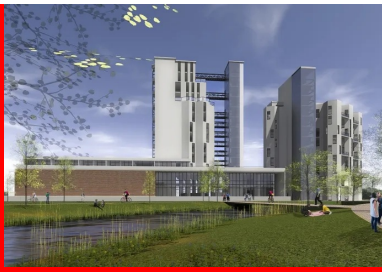
Les silos de Moisy
