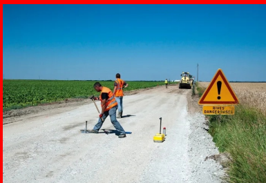
À droite, contrôle de la régularité de l'épandage et de la quantité des liants réalisé par la méthode dite « à la bêche ». À gauche, préparation d'un test de compacité. En médaillon, résultat à l'issue du malaxage : le liant clair a été finement mélangé avec le matériau de l'ancienne chaussée.
