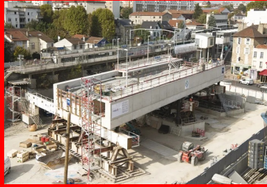
Avancée du chantier à Arcueil - Cachan avec mise en place du pont-dalle.
