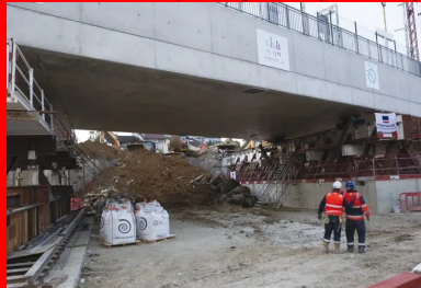
Pont-dalle à Arcueil - Cachan. Après le coulage et quelques jours avant le ripage.
