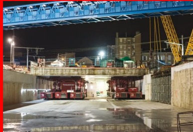
Ripage de la dalle de couverture pour la gare Fort d'Issy-Vanves - Clamart
