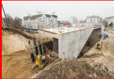
Ripage du pont-rail à Champigny.
