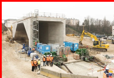
Ripage du pont-rail à Champigny.
