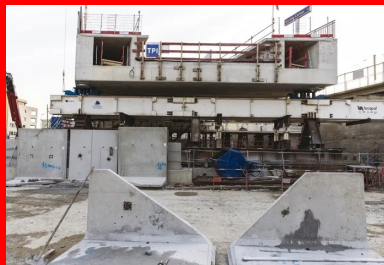
Début de l'opération de ripage du pont-dalle.
