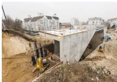
Ripage du pont-rail à Champigny.
