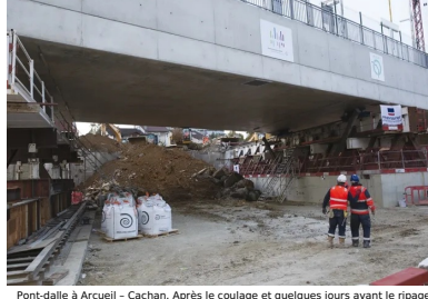
Pont-dalle à Arcueil - Cachan. Après le coulage et quelques jours avant le ripage.
