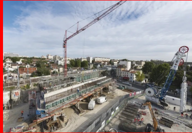
Réalisation du pont-dalle.
