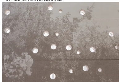
Détail des parois de béton ornées par le plasticien Stefano Arienti.
