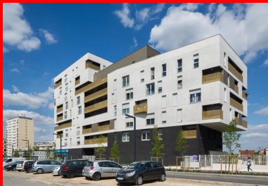
Décalages des volumes et espaces en creux.
