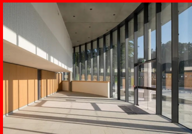
Le plafond du hall principal, façon faux plafond en béton gris autoplaçant, « suspendu » à la dalle porteuse des étages supérieurs.
