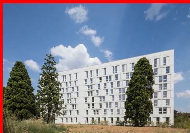
La façade ouest, plus fermée car exposée aux nuisances et composée de panneaux de béton blanc dépolissant.
