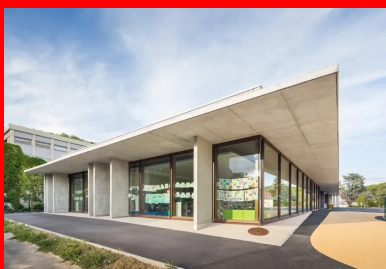
L'auvent de la façade ouest repose en partie sur des voiles béton verticaux qui complètent le dispositif brise-soleil.
