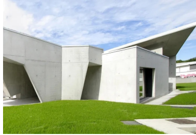
Le porte-à-faux signale l'accès et invite à entrer dans le siège de l'entreprise.
