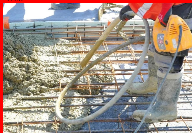
Une aiguille vibrante est utilisée pour chasser les bulles d'air et assurer une bonne compacité.
