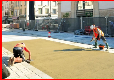
Achèvement des travaux devant l'entrée du marché couvert.
