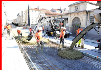
Le béton est délivré directement à la goulotte, puis réparti sur une épaisseur de 23 cm.
