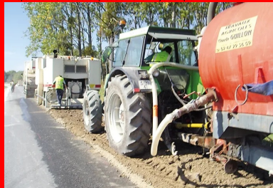
L'atelier de retraitement de chaussée réalise plusieurs opérations : fraissage, épandage et malaxage.
