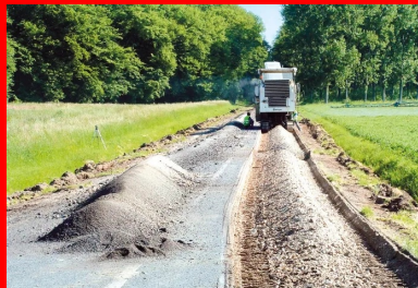
L'ancienne chaussée est un gisement de matériaux qui est possible de valoriser
