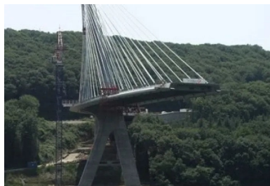
Construction du pont à haubans de Térénez (29), inauguré en 2011 : pylône en lambda renversé. (c) photo Noëli Richet
