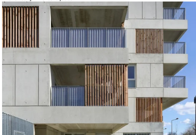
Les raccords verticaux entre les différents corps de bâtiment forment des failles en retrait jouant sur les hauteurs.
