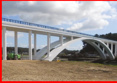
Pont Kerisper après travaux
