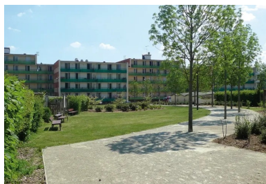
La rénovation du quartier maison Rouge a consisté à lui donner une unité, notamment grâce à des espaces verts de transition. Au premier plan, une allée en sable stabilisé d'authevernes (27) renforcé avec 5 % de ciment.
