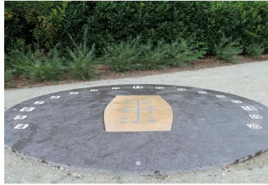
Ce cadran solaire analemétique a été réalisé en béton chocolat et ton pierre avec des incrustations de sérigraphies métalliques.
