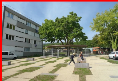
Des banquettes en béton chocolat ponctuent cet espace réalisé avec des dalles en béton coulées en place, tan pierre avec carbure de silicium désactivé, et des joints en gazon
