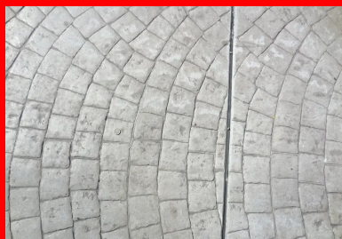
La zone d'arrêt du bus est matérialisée au sol par une finition en béton imprimé.
