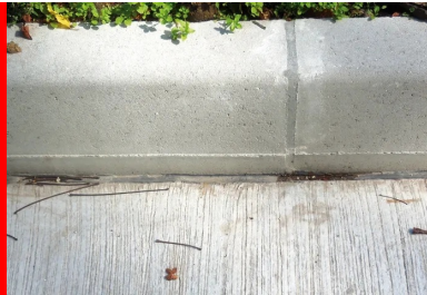
la zone de circulation est en béton balayé
