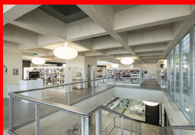
Pallier du deuxième étage. À droite, la boîte à lumière et à vent qui permet d'éclairer le cœur du bâtiment.
