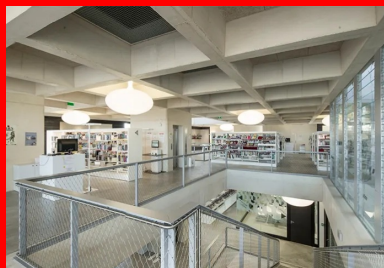
Pallier du deuxième étage. À droite, la boîte à lumière et à vent qui permet d'éclairer le cœur du bâtiment.
