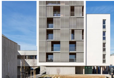
Les volets persiennés coulissants des loggias protègent du soleil et des vues.
