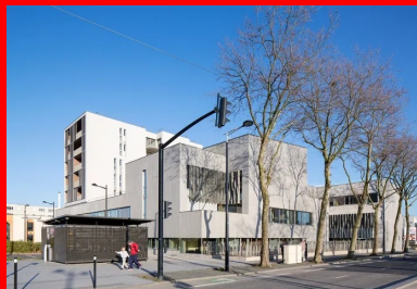
À l'arrière du siège social, le bâtiment des logements, protégé des nuisances sonores de l'avenue.
