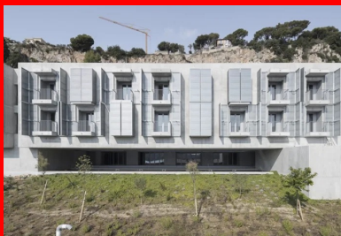
Réinterprétant l'archétype des persiennes, les balcons sont protégés par des volets métalliques qui protègent du soleil tout en créant des brise-vue entre balcons.
