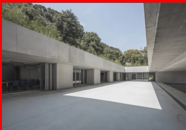
autour du patio, les salles communes possèdent des baies totalement escamotables pour gommer la limite entre l'intérieur et l'extérieur.
