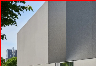
L'enveloppe du bâtiment est rythmée par les grands plans vitrés et les parois verticales en béton gris poli ou bouchardé. Des éclats de miroir sont incorporés au béton. Ils scintillent sous le soleil et animent les façades de façon changeante et inattendue.
