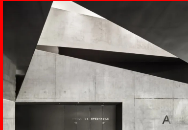
Le hall se dilate verticalement par un grand vide ascensionnel qui met en relation tous les éléments du programme.
