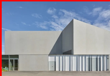
L'enveloppe du bâtiment est rythmée par les grands plans vitrés et les parois verticales en béton gris poli ou bouchardé. Des éclats de miroir sont incorporés au béton. Ils scintillent sous le soleil et animent les façades de façon changeante et inattendue.
