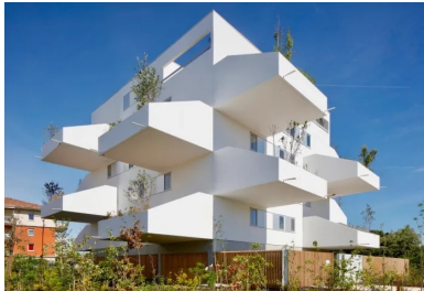
Les abords arborés des immeubles forment une zone tampon entre l'espace public et l'espace privé.
