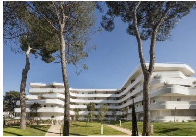
Les garde-corps des balcons filants s'enroulent autour de la façade et ondulent.
