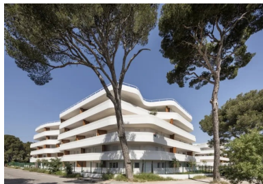
De loin, les garde-corps, composés de béton et de métal, se lisent comme des rubans blancs homogènes.
