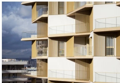
La modénature du béton joue avec la lumière.
