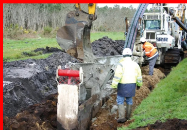
Disposés en tréfle au fond de la tranchée, les câbles sont recouverts de remblai liquide, puis la tranchée est comblée avec la terre excavée. Un grillage de plastique rouge inséré dans la tranchée signale la présence de la ligne haute tension.
