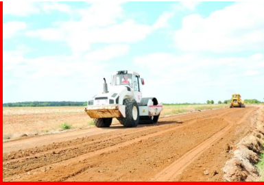
L'atelier de compactage entre en action avec l'intervention d'un rouleau vibrant.
