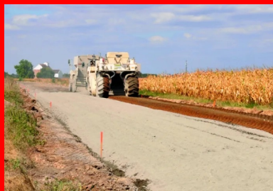
Une Wirtgen 2400 intervient pour mélanger le matériau de l'ancienne chaussée avec le liant sur une épaisseur de 35 cm.
