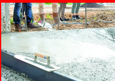
La talochage des premières planches d'ossais s'est effectué manuellement, sans difficulté.
