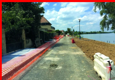
Avant. L'ancien chemin au début des travaux.
