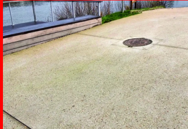
Le cheminement s'ouvre régulièrement, côté fluvial, sur des aménagements - façon belvédères - avec points de vue avancés sur la Seine (en arrière-plan). Au premier plan et en médiation, un joint de dilatation.
