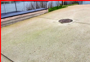
Le cheminement s'ouvre régulièrement, côté fluvial, sur des aménagements - façon belvédères - avec points de vue avancés sur la Seine (en arrière-plan). Au premier plan et en médiation, un joint de dilatation.
