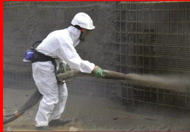
Opérateur de projection en voie mouillée
