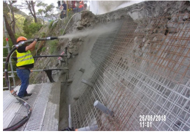
Confortement de talus par voie sèche.
