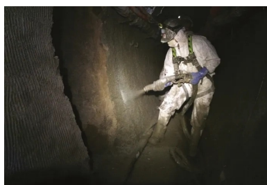
Projection de mortier renforcé de fibres métalliques amorphes pour le renforcement de réseaux hydrauliques.
