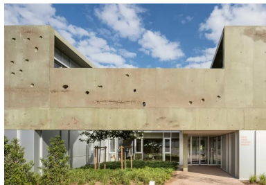
Pour accéder au centre dédié aux enfants, on se glisse sous l'enveloppe de béton protectrice.
