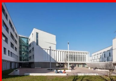
Inscrit dans la ville, le lycée est aussi un univers urbain à part entière où la cour est conçue comme une place publique.
