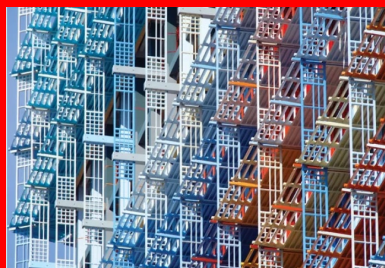
Tout en dentelle et couleurs, la grille en Bflup des façades sud et ouest semble particulièrement légère.
