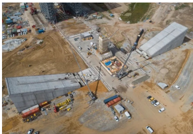
Les deux carnaux évacuent les gaz de propulsion émis lors du décollage.
