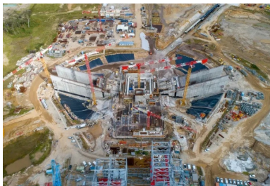
Le massif de lancement est le cœur battant d'ELA 4, c'est sur cet ouvrage semi-enterré en béton armé que s'appuiera le lanceur pour décoller.
