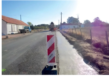
La chaussée ayant été sciée à 10 cm du bord, le Macos est mis en place sur des largeurs variant de 30 cm à 2 m.
