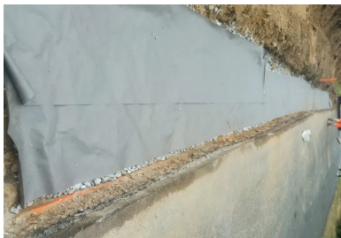
Une base drainante de 20 cm a été constituée en fond de fouille. Elle a été réalisée en matériaux drainants de granulométrie 20/40 et placés dans un géotextile anticontaminant (chaussette). Elle a facilité l'essorage du Maces.
