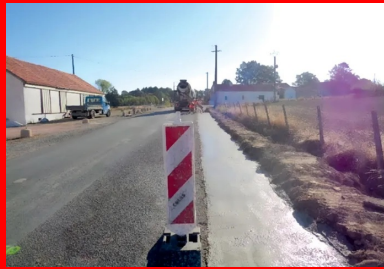
La chaussée ayant été scindée à 10 cm du bord, le Macés est mis en place sur des largeurs variant de 30 cm à 2 m.
