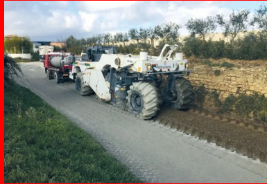
L'atelier de traitement d'Eurovia intervient sur une épaisseur de 32 cm et sur une largeur de 2,50 m par passage
