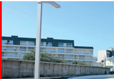
L'éclairage public a été entièrement révisé avec l'utilisation de diodes électroluminescentes (LED).
