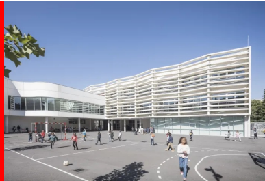
Les brise-soleil en béton blanc animent la façade sud.
