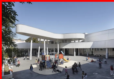
L'architecte a développé, grâce au béton, tout un univers enfantin.
