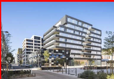
Les trois bâtiments du site dessinent un petit pôle urbain.
