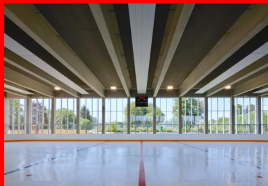
La piste de la patinoire synthétique. Les trois façades entièrement vitrées et la structure en béton laissé apparent contribuent à la qualité spatiale de cette grande salle.
