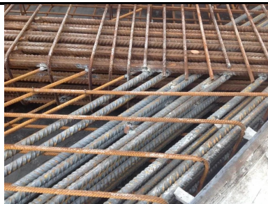
Réparation des ouvrages en béton armé dégradés par corrosion des armatures
