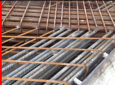
Réparation des ouvrages en béton armé dégradés par corrosion des armatures
