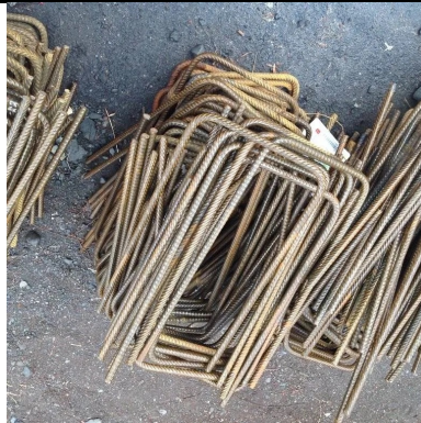
Réparation et renforcement des structures par des armatures passives additionnelles
