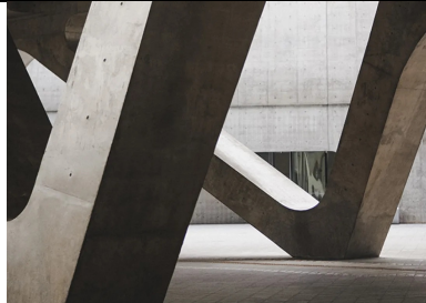
Réparation et renforcement des structures en béton au moyen de matériaux composites
