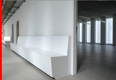
À l'étage des salles de cours, les fenêtres verticales toute hauteur, posées entre les brise-soleil, rythment la circulation dans le couloir et diffusent une belle lumière naturelle dans les salles.
