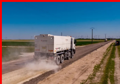
L'épandeur à dosage pondéral assure la répartition homogène du liant hydraulique routier à raison de 26 kg au m 2 .
