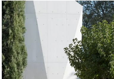
Vues de la façade sud
