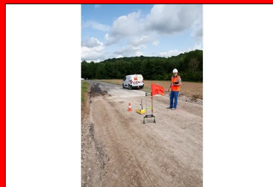
Contrôle de compactage au gamma-densimètre
