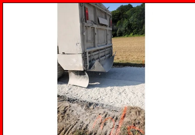
Épandage du liant
