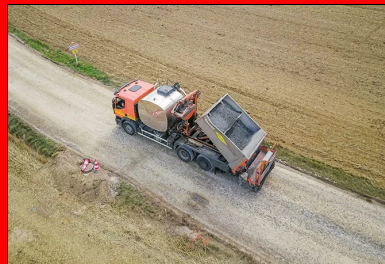
Mise en œuvre de l'enduit de protection
